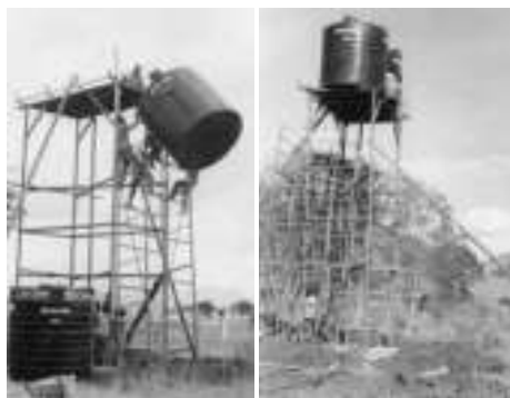
Zwei Tanks mit je 5000 Liter, es können täglich 5000 Liter hochgepumpt werden
